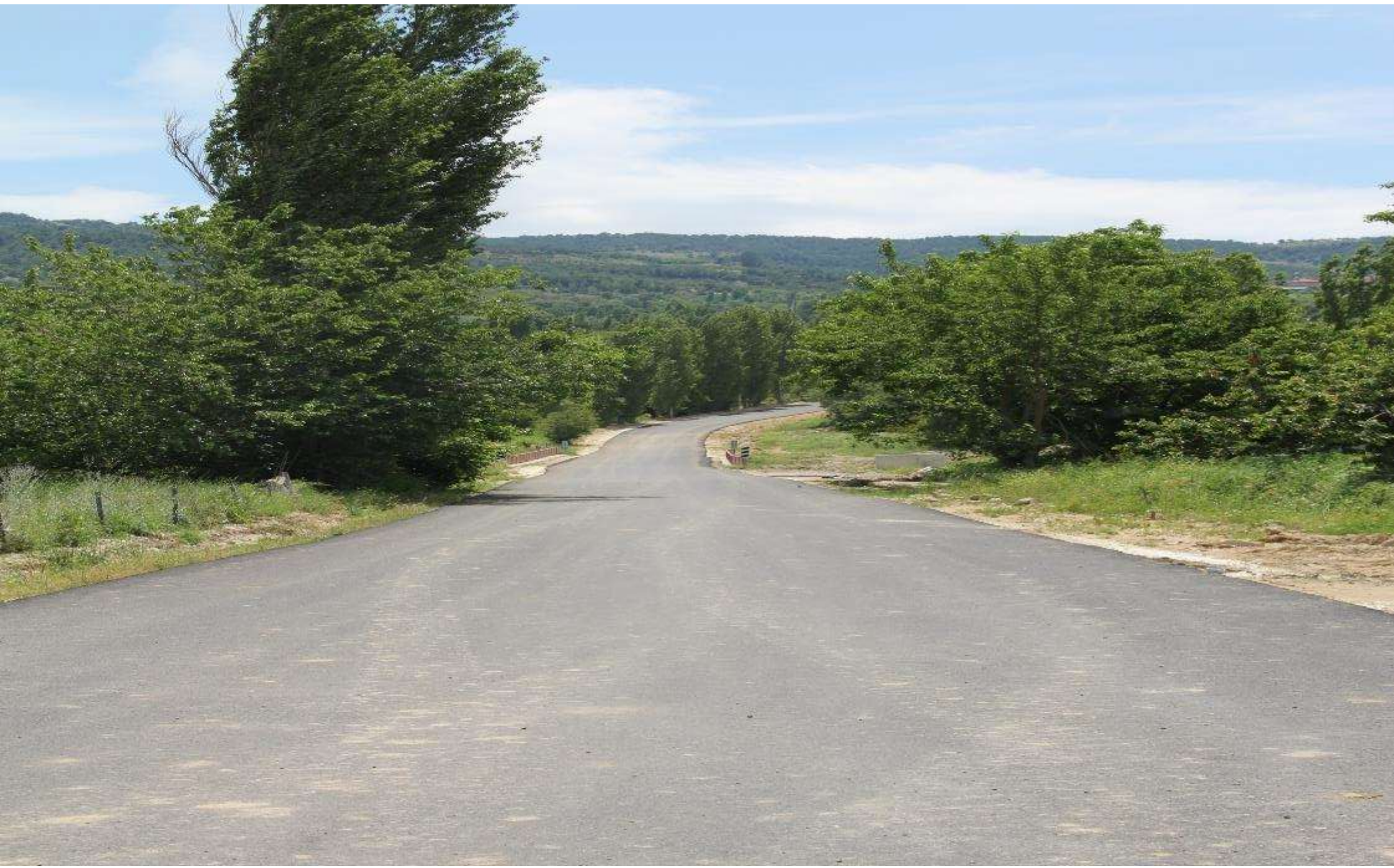
Şaphane-Gaipler BSK Sıcak asfalt çalışması
