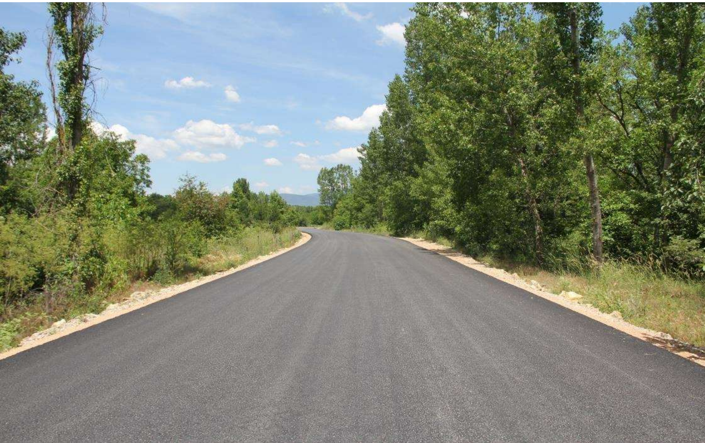
Simav-Boğazköy BSK Sıcak asfalt çalışması
